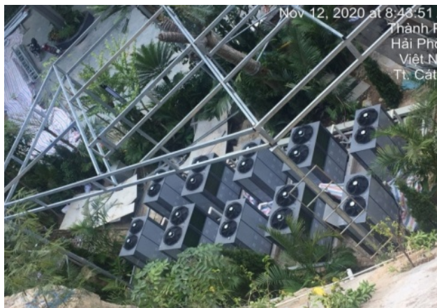
Dự án lắp đặt hệ thống kho lạnh khu Resort Flamingo tại Cát Bà Flamingo Resort in Cat Ba
