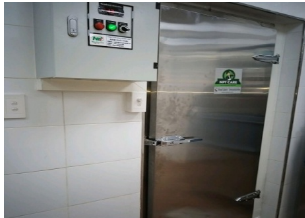
Lắp đặt hệ thống kho chuỗi nhà hàng của Lotteria Lotteria restaurant chain
