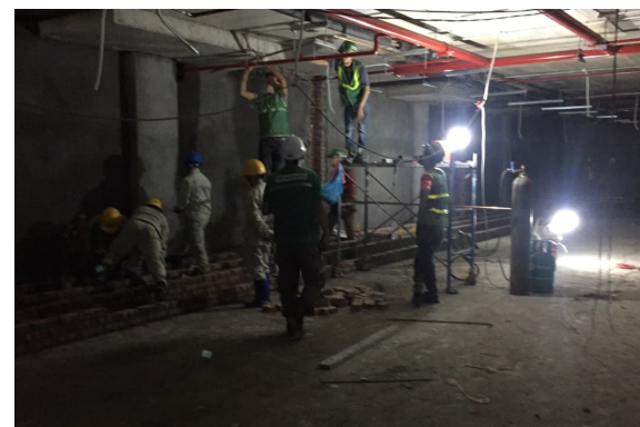
Thi công hệ đường ống đồng Installation of copper pipeline systemsite
