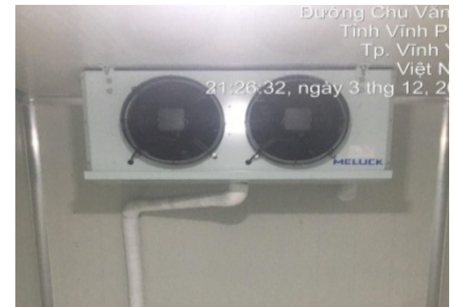
Lắp đặt hệ thống kho chuỗi nhà hàng của GGG Golden Gate restaurant chain
