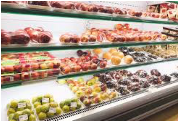
Dự án lắp đặt hệ thống tủ siêu thị cho TTP ở Cẩm Phả, Quảng Ninh Supermarket cabinet system of TTP
