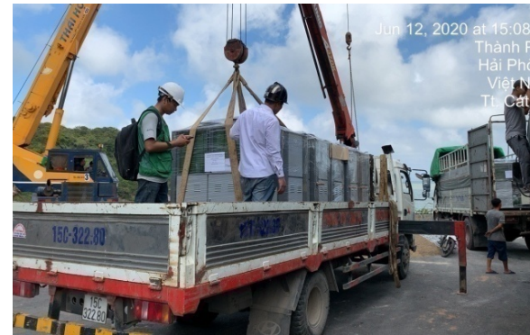
Cẩu chuyển cụm máy đến công trình Move the machine to the construction site
